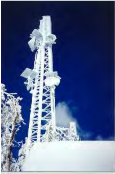
Bild 109: Sendemast mit Vereisung vor (links) und nach dem Einsturz (rechts) [Lit 14]
