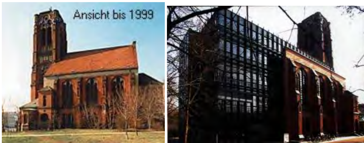
Bild 2: Umwidmung und Umbau der Auferstehungskirche Berlin in ein Umweltforum [Lit 105]
