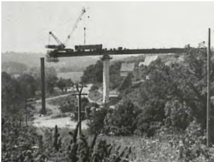
Bild 91: Brückenbau Zeulenroda. Der 80 t Montagekran steht am Freivorbauende [Lit 40]
