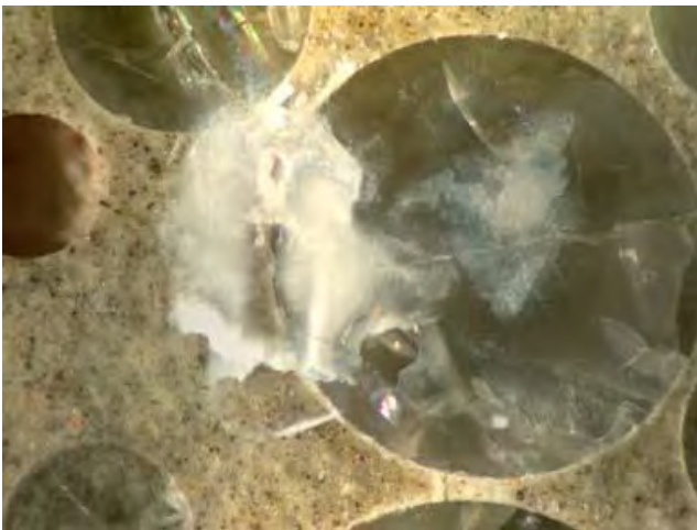
Bild 127: Risse in der Matrix und in der Gesteinskörnung verursacht durch ASR [Lit 55]
