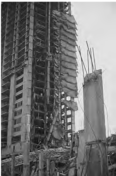
Bild 137: 1973 während des Baus eingestürztes Bürogebäude Bailey's Crossroads, Fairfax, Va. [Lit 13]
