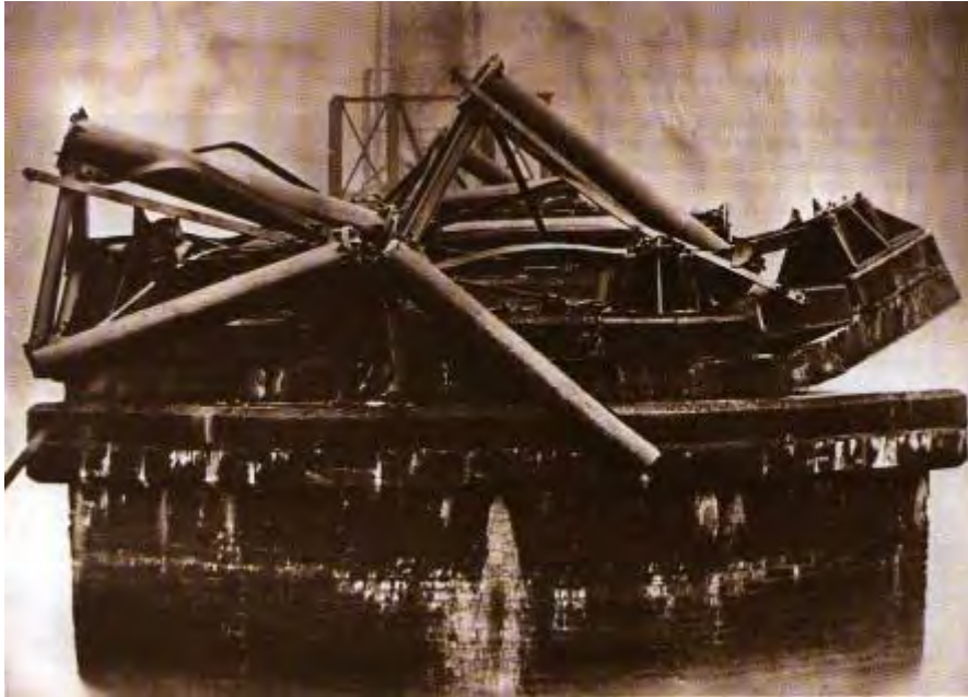
Bild 104: Zerstörter Pfeilerfuß No. 32 mit Resten der Stütze
