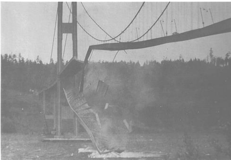
Bild 106: Einstürzende Tacoma Narrows Brücke am 7.11.1940 gegen 11:00 vormittags [Lit 106]
