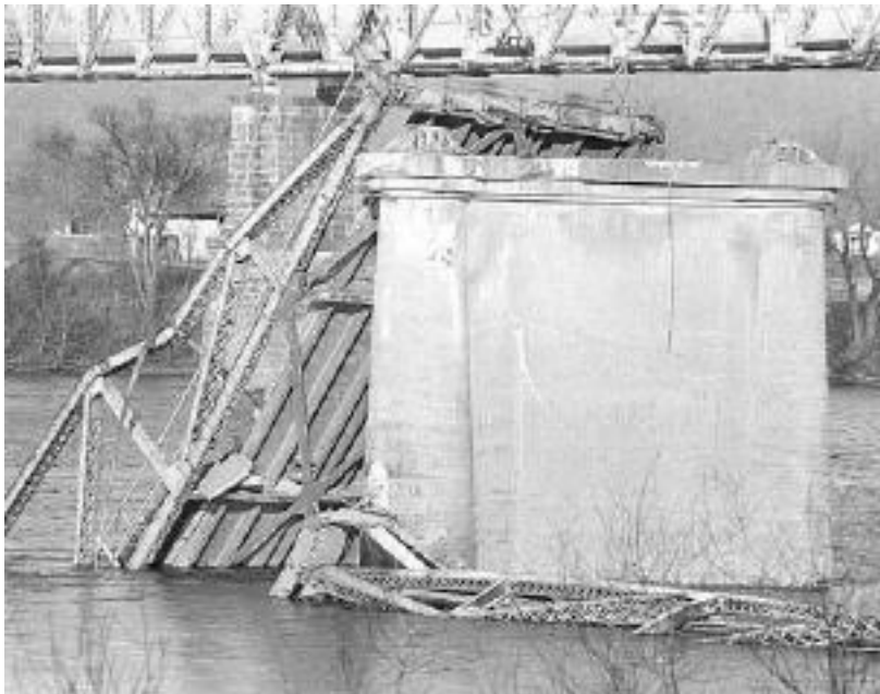
Bild 94: Reste der Silver Bridge nach dem Einsturz am 15.12.1967 [Lit 56]
