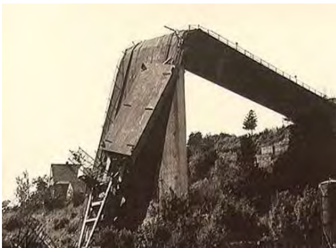
Bild 92: Die Baustelle mit dem abgeknickten Brückenträger nach dem Unglück [Lit 40]
