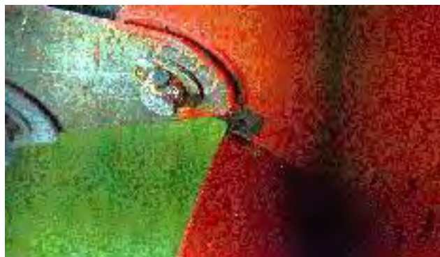
Bild 114: Schematische Darstellung der Seilkopfverankerung (links) und praktisches Beispiel mit beginnender Korrosion (rechts) [Lit 44]
