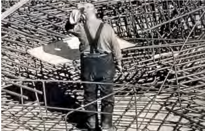
Bild 130: Unübersichtliche Bewehrungsführung
