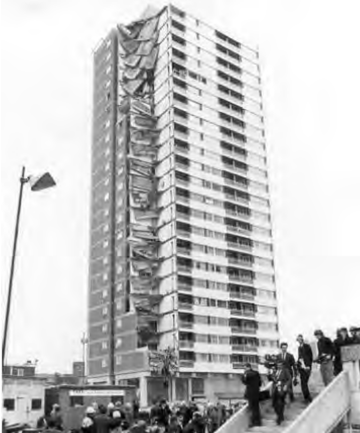
Bild 139: Hochhaus Ronan Point, London, nach dem partiellen Einsturz am 16. Mai 1968
