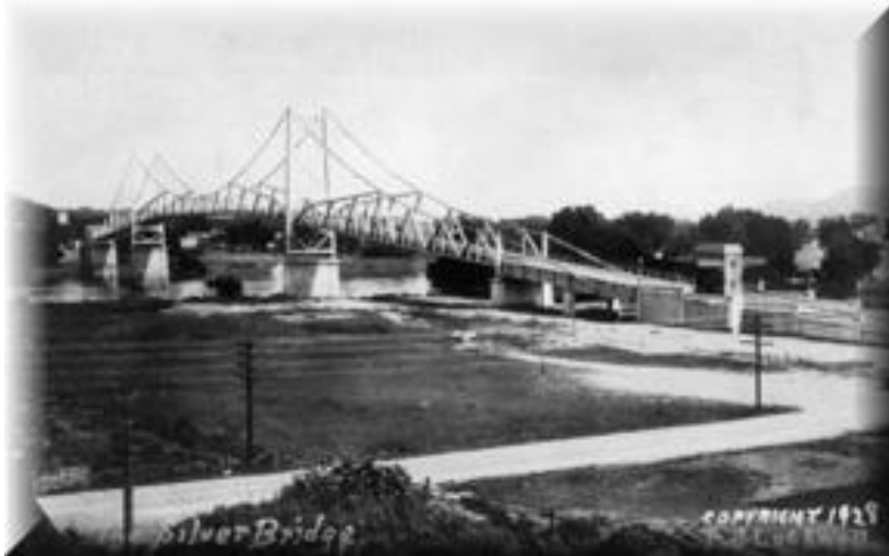
Bild 93: Silver Bridge über den Ohio 1928 [Lit 70]
