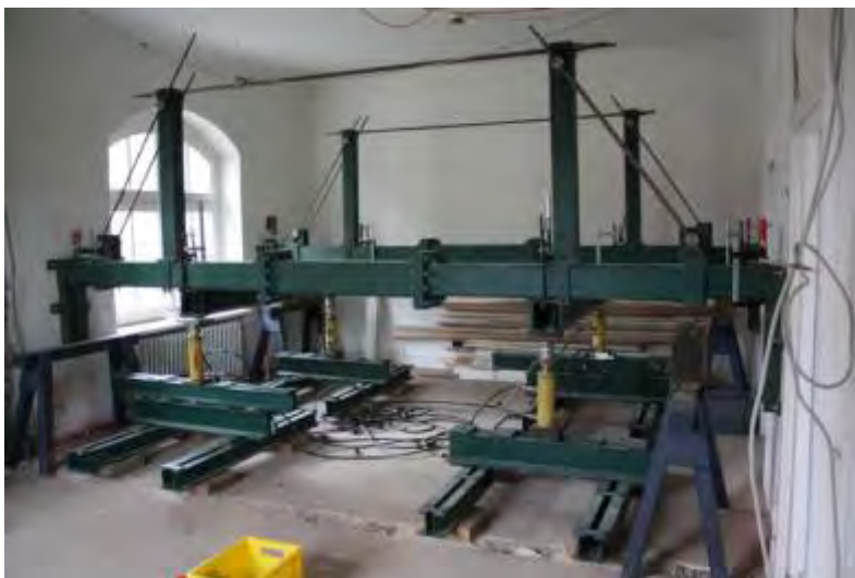
Bild 57: Probelastung einer Decke [Lit 67]
