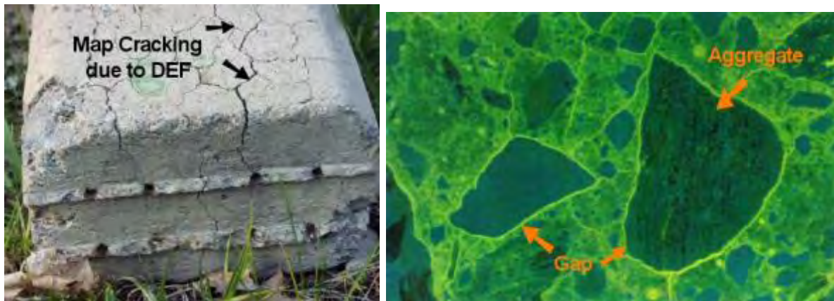
Bild 125: Durch sekundäre Ettringitbildung geschädigter Beton (links) und typische Rissbildung (rechts) [Lit 16]
