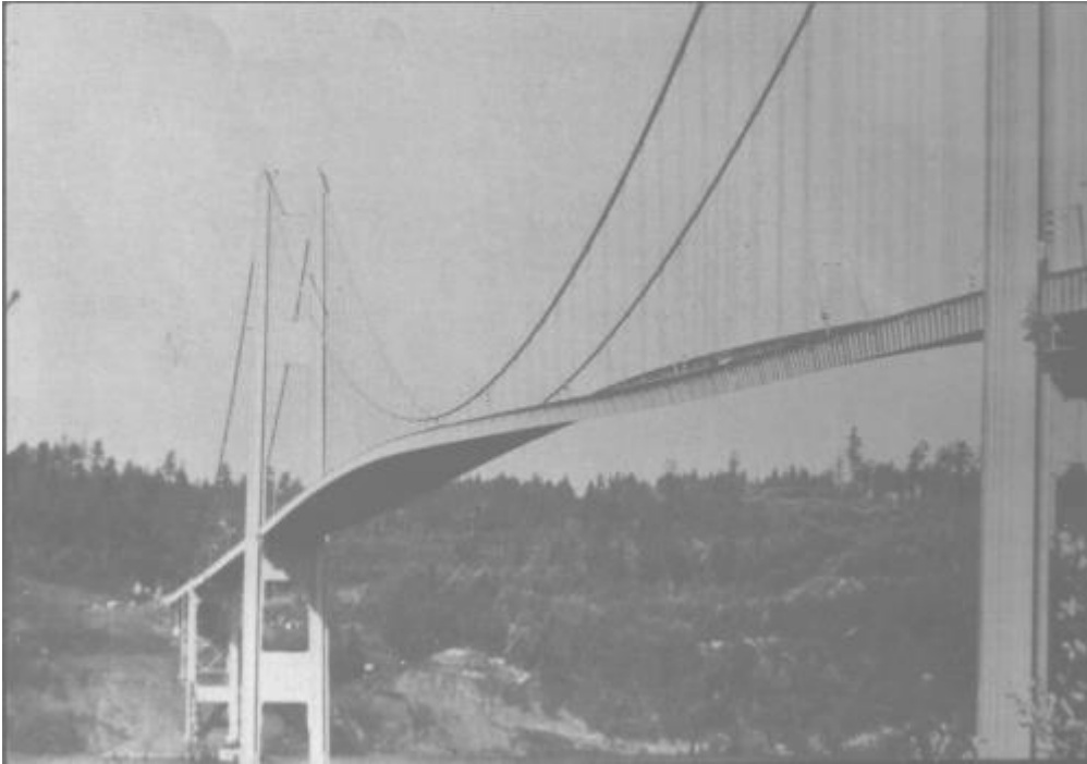
Bild 105: Tordierter Brückenträger der Tacoma Narrows Brücke [Lit 106]
