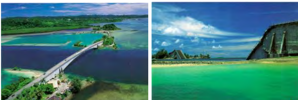
Bild 15: Koror - Babeldaob Brücke in Mikronesien, links nach der Eröffnung 1977 und rechts kurz nach dem Einsturz 1996 [Lit 71]
