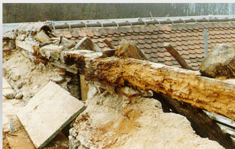
Undichtes Dach
