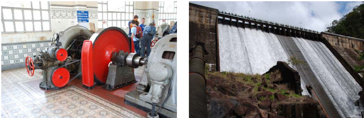
Bild 17: Links: Francisturbine der Waffenfabrik; Rechts: Hochwasserentlastungsanlage einer Wasserkraftanlage
