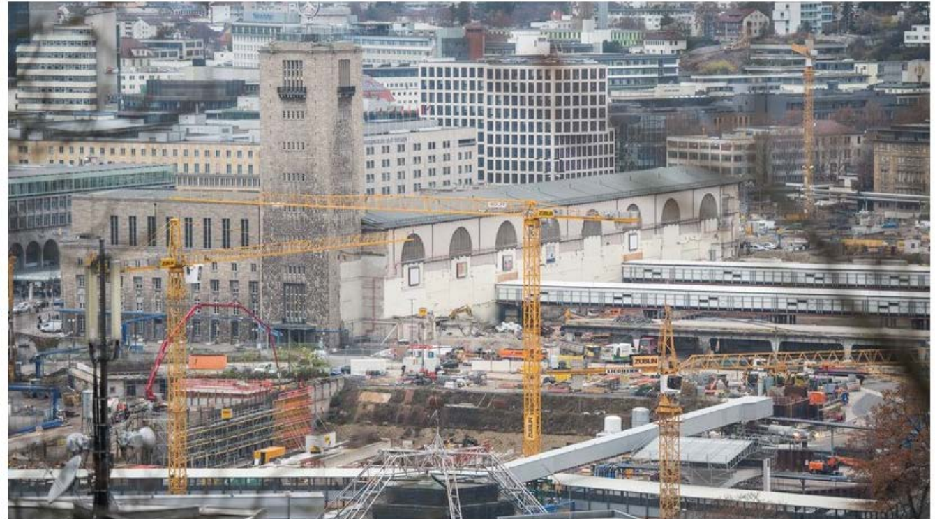
Großbaustelle im Herzen Stuttgarts: Der Neubau des Bahnhofs Stuttgart 21 © Lino Mirgeler/dpa
