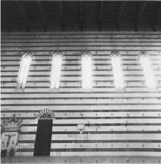
FIG. 15. Façade of the nave (40 mm lens).
