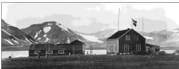
Abb. 2: Gebäude des Observatoriums Ebeltoftthamna, von links: Lagerschuppen, Ballon- und Drachenschuppen, Hauptgebäude. (Quelle: Nachlass Max Robitzsch).
