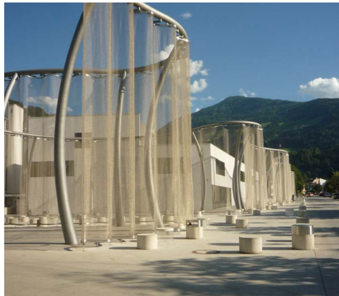
Granitpoller und ein transparenter Vorhang aus Stahlringen schützen ein Gebäude in Österreich – unauffällig und zum Verweilen einladend.
