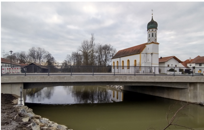
Die Digitale Brücke Schwindegg in der Ansicht
