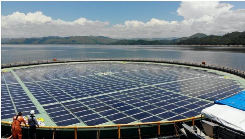
Im Rahmen der Abschlussarbeit soll das Tragverhalten der Struktur untersucht werden. Dabei spielt die Interaktion der Struktur mit dem Wasser sowie die genaue Dimensionierung von Membran und Schwimmring eine wesentliche Rolle. Des Weiteren sollen die Effekte einer möglichen Vorspannung der Membran untersucht werden.
