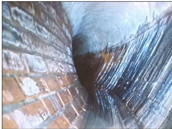
Abb. 14: Eiprofil DN 700/1050 [HÜMMER et al., 2013].
