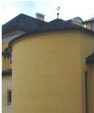
Abb. 23: Gebäude mit rundem Grundriss
