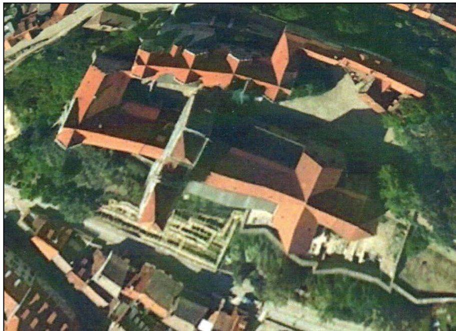
Abb. NO 2 Der Achsknick zwischen Chor und Schiff bei der Stiftskirche in Quedlinburg
