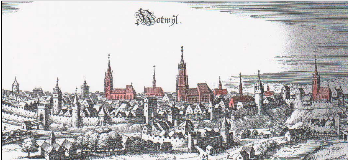
Abb. 15 Stadtansicht von Rottweil aus südlicher Richtung nach Merian um 1650
