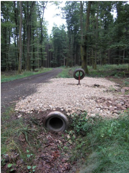
Abb. 3-33: Zusätzliche Kennzeichnung einer Eigentumsgrenze mit Eisenrohr und Autoreifen durch den Waldeigentümer im Waldflurbereinigungs-verfahren Lissingen (Hinz 2010)
