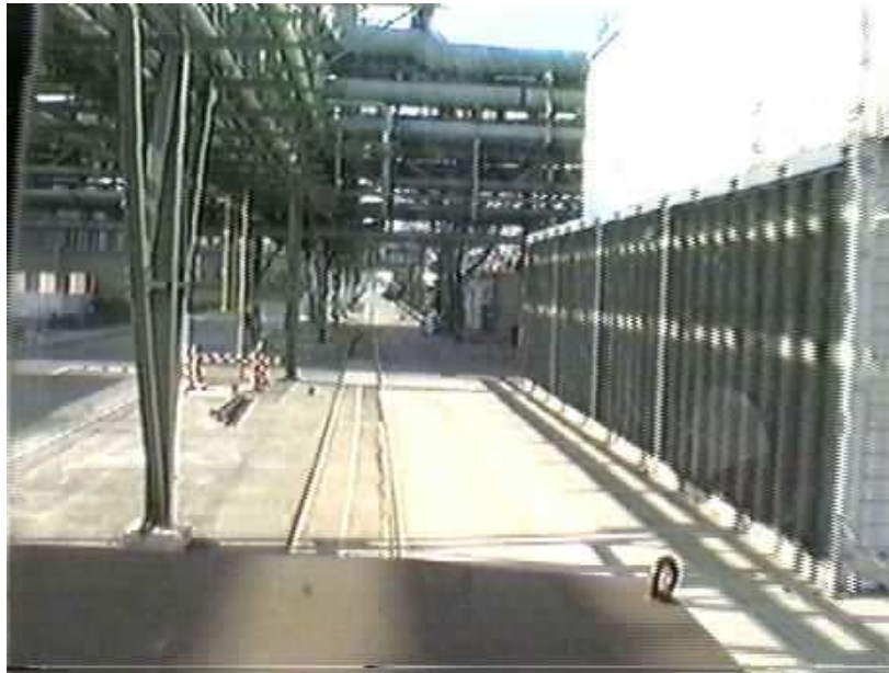
Abbildung 2.15: Beispiel für die Gleisumgebung bei der BASF
