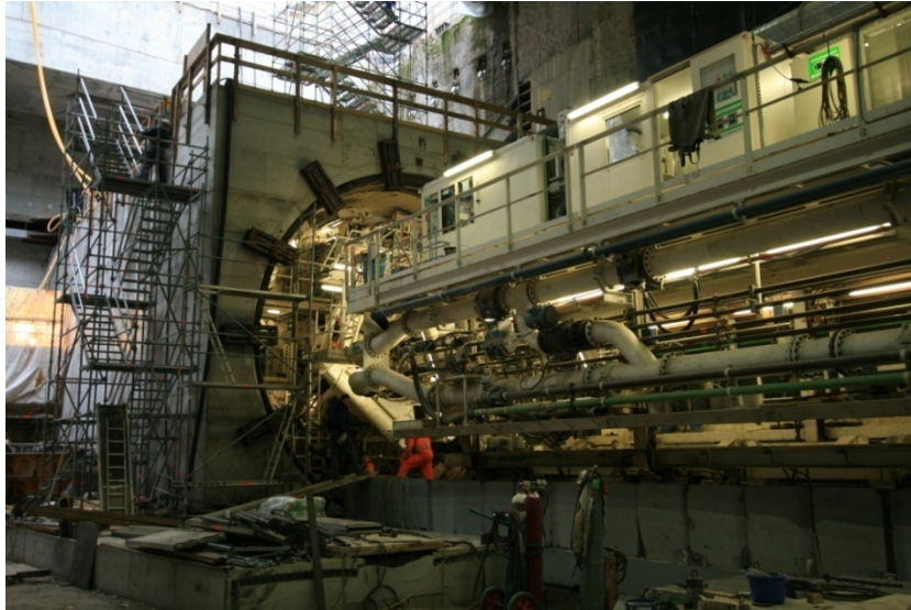
Abb. 11 Maschine: Startbereit im Betontopf
