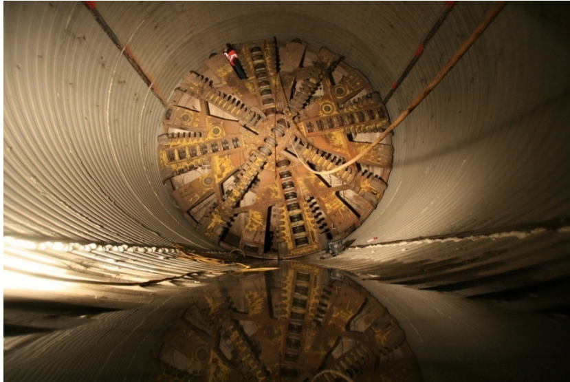
Abb. 10 Betontopf in der Startsituation: Maschine in der „Betonhöhle“
