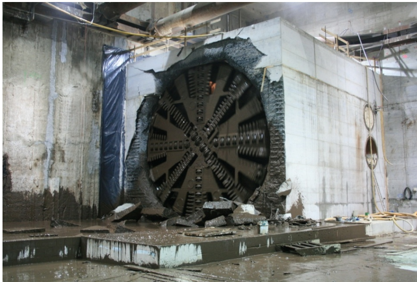
Abb. 8 TBM nach Durchschlag im Betontopf
