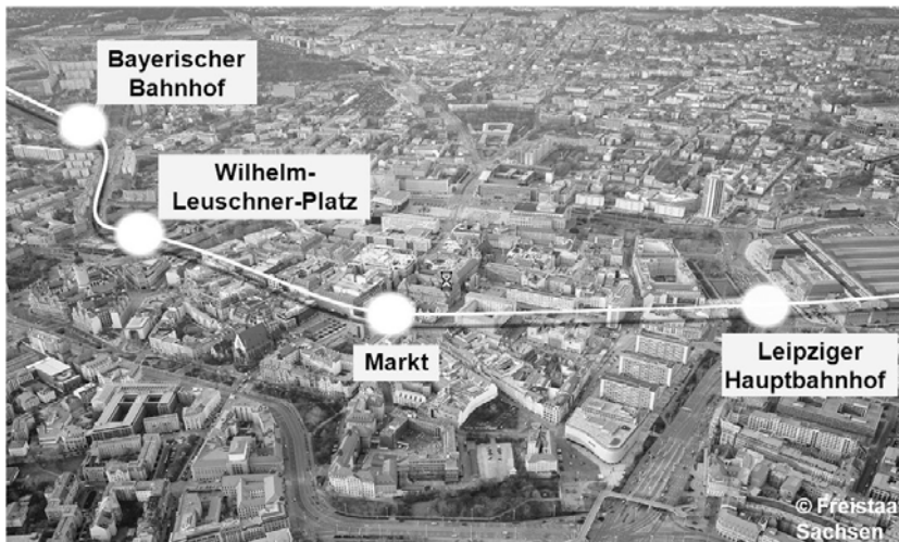
Abb. 1 Übersicht des City-Tunnel Leipzig
